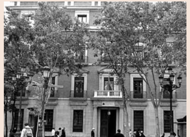
Sede de la Dirección General de los Registros y del Notariado.
